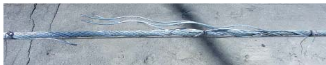
Рис. 7. Обычный кабель ОКГТ с повреждёнными сильным ударом молнии проводами внешнего слоя (из алюминиевого сплава)
