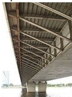
Балка жесткости пролетного строения моста
